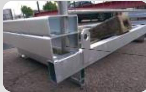
Les plots passent sous les clôtures et sont calés dans le bac inférieur
